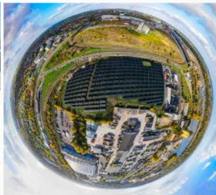
991,92 kWp Freiflächenanlagen Stadt Magdeburg
