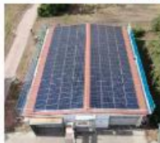
56 kWp landwirtschaftliche Lagerhalle Wanzleben-Börde
