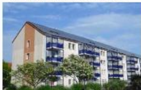
160,9 kWp Wohnungsbaugesellschaft Bitterfeld
